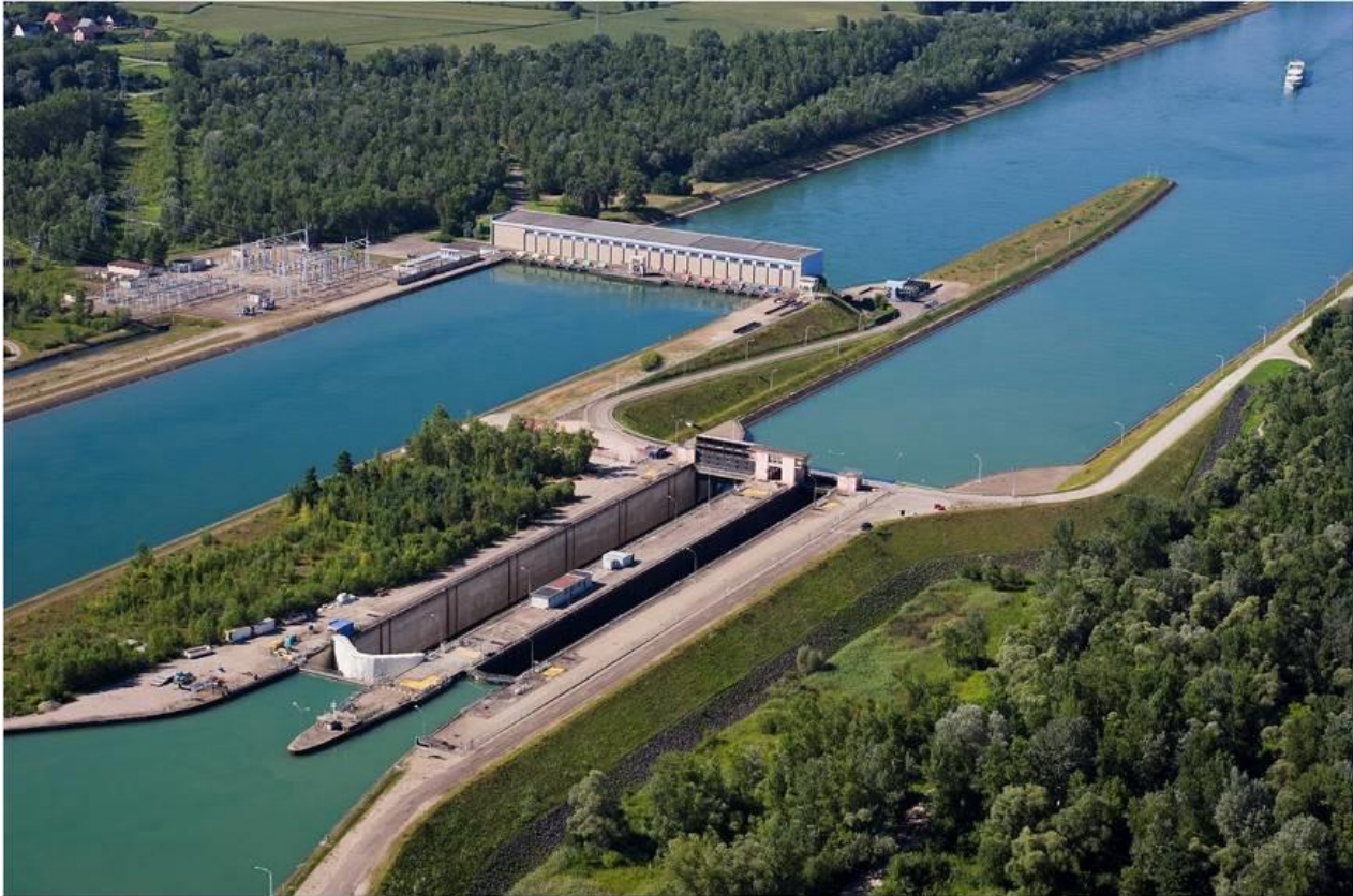
Figure 4 : Photo aérienne de la centrale de Rhinau et des écluses
