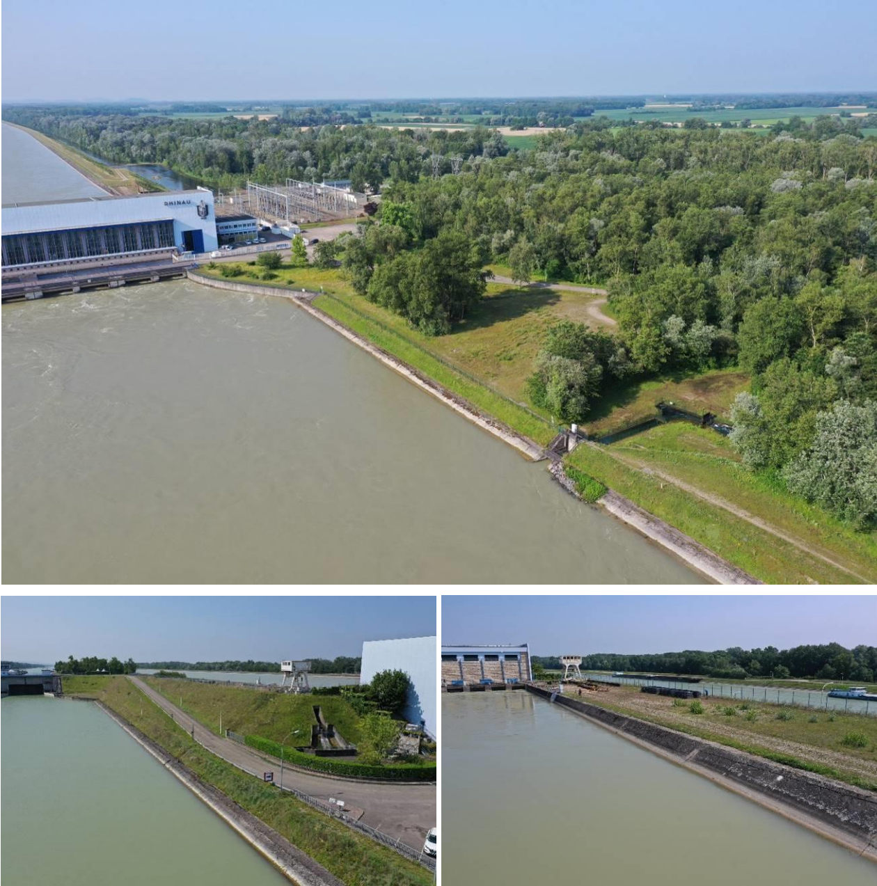
Figure 30 : Photos des berges artificialisés sur les zones de travaux
